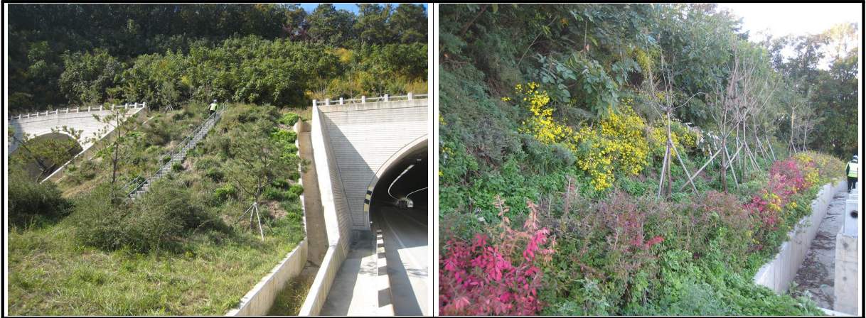
【사진 3.3.7】 사면 전경
