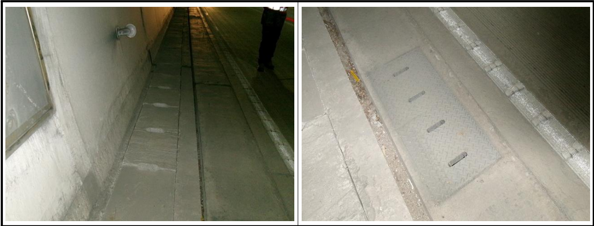
【사진 3.3.8】 공동구 및 배수시설 전경
