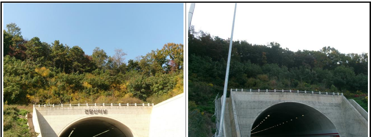
【사진 3.3.20】 사면 전경
