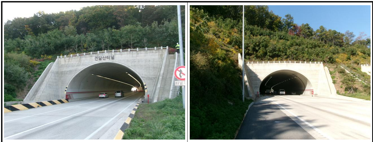
【사진 3.3.5】 갭문 전경
