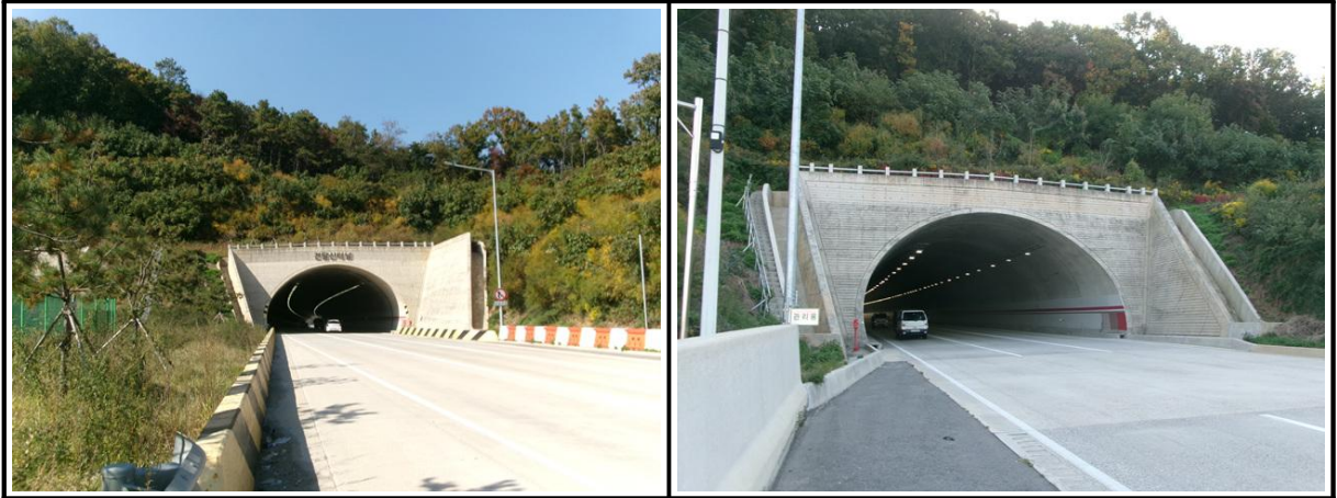
【사진 3.3.14】 라이닝 천단부 전경
