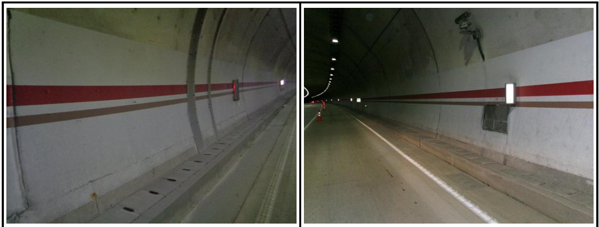
【사진 3.3.3】 라이닝 측벽부 전경
