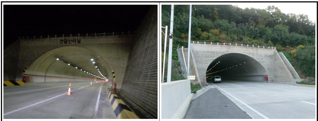
【사진 3.3.18】 갭문 전경
