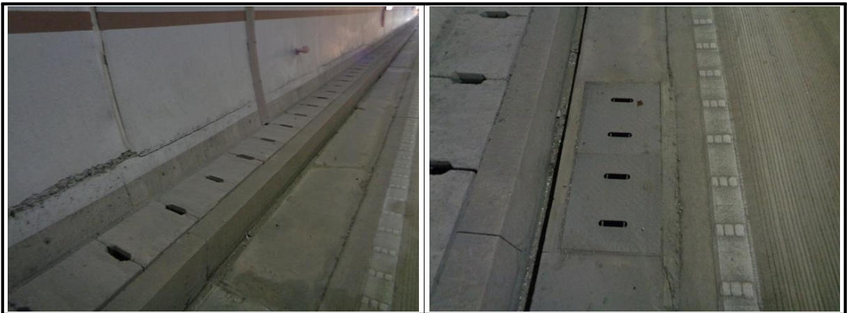
【사진 3.3.21】 공동구 및 배수시설 전경
