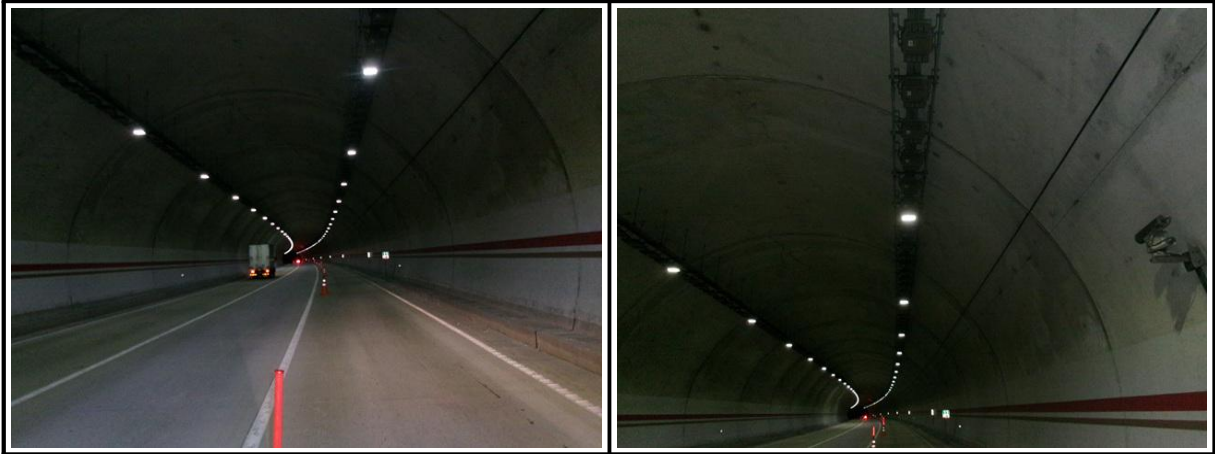
【사진 3.3.1】 라이닝 천단부 전경
