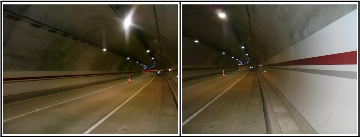
【사진 3.3.16】 라이닝 측벽부 전경
